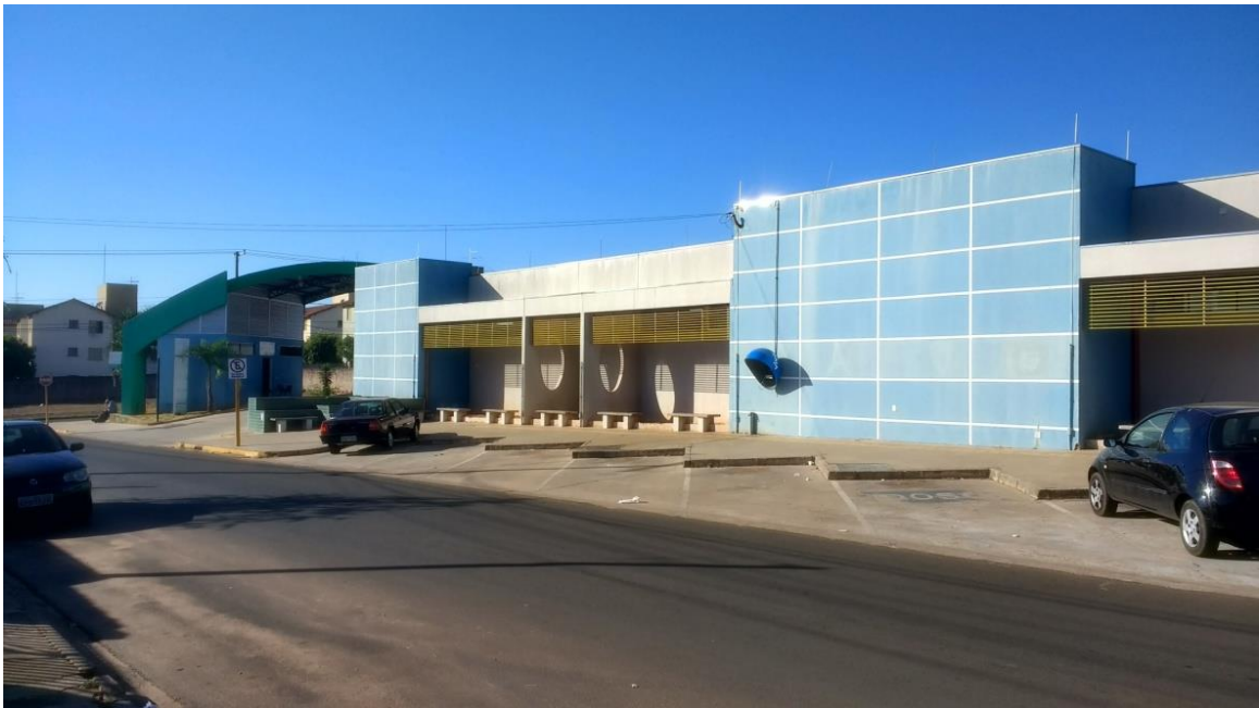
Foto: UPA GEISEL REDENTOR - Fachada
